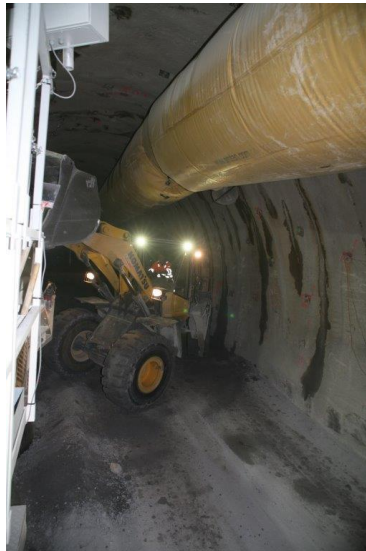
Das zur Gänze in Niederösterreich liegende, über 7 km lange Baulos „Tunnel Gloggnitz“ wird von der Arge Hochtief Infrastructure Austria, Implenia Österreich und Thyssen Schachtbau zur Gänze im Bagger- und Sprengverfahren hergestellt.
