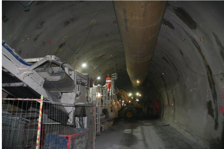
Das zur Gänze in Niederösterreich liegende, über 7 km lange Baulos „Tunnel Gloggnitz“ wird von der Arge Hochtief Infrastructure Austria, Implenia Österreich und Thyssen Schachtbau zur Gänze im Bagger- und Sprengverfahren hergestellt.
