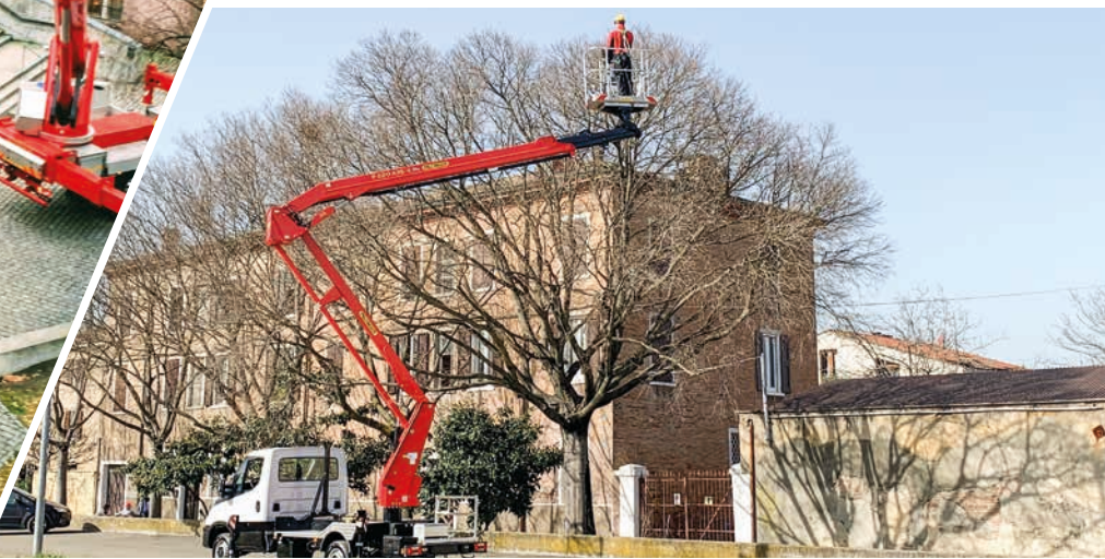
Installation von Solar Panelen mit der P 300 KS
