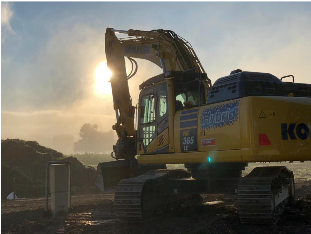
Große Aushübe und Betonabriss lassen sich mit dem Hybridbagger schnell bewerkstelligen.
