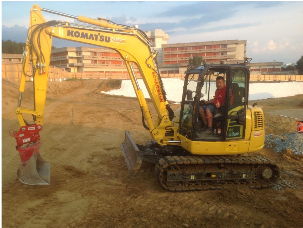
Der Fahrer Nino Karlovits („Schermann Erdbau- und Recycling GmbH“) bedient den PC80MR-5 von Komatsu inklusive der modernen 3D-Steuerung X-53i von Topcon. Gebaut wird das neue Krankenhaus in Oberwart.
